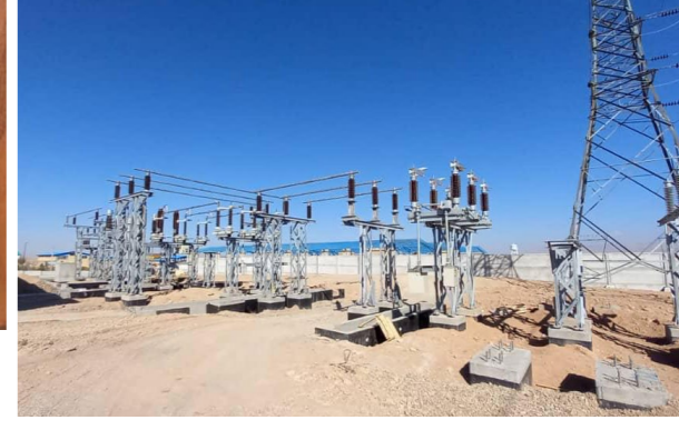
عملیات احداث پست‌های ۲۰/۶۳ کیلوولت مهرگان قزوین و نوآوران زنجان
